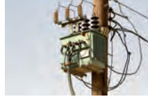
الشكل 16-6 تستخدم المحولات الخافضة للتقليل من الجهود الكهربائية العبيرة في خطوط نقل القدرة إلى مستويات تناسب المستهلكين في أماكن الاستخدام.
